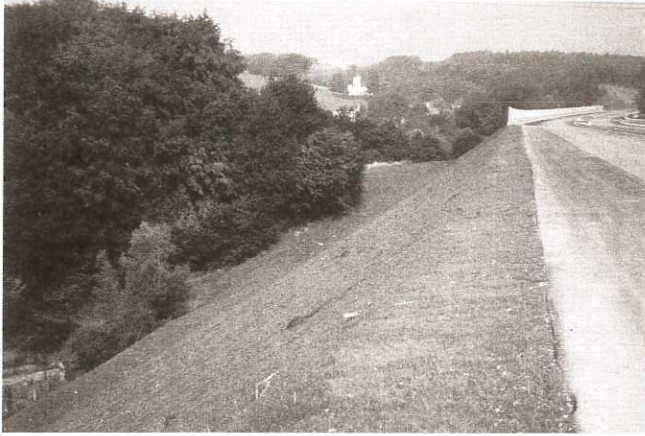
Abb. 2: Unverzügliches Herstellen einer oberflächenfestigenden Pflanzendecke
